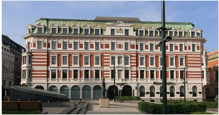
Materialkontrast på rik fasade i klassiserende nyrenessanse. Prinsens gate 26, «Schjøllgården», oppført 1880. Arkitekt: Henrik Nissen. Tak-etasje påbygd 1898, og arkaden på venstre side er senere forstørret. (Foto: snl.no)
